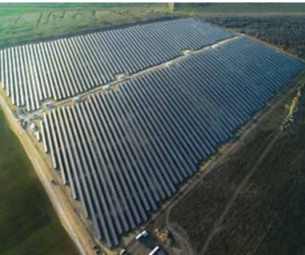
08 Usina Fotovoltáica de larga escala de 15 MW na Ucrânia
